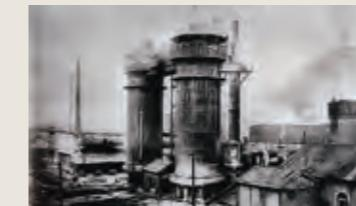
官営釜石製鉄所25t高炉
