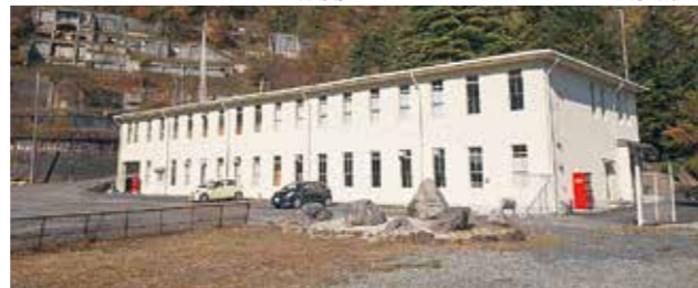
旧釜石鉱山事務所
